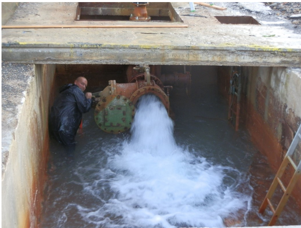
Uzavírání bočního šoupěte před zapuštěním sondy do vrtu
